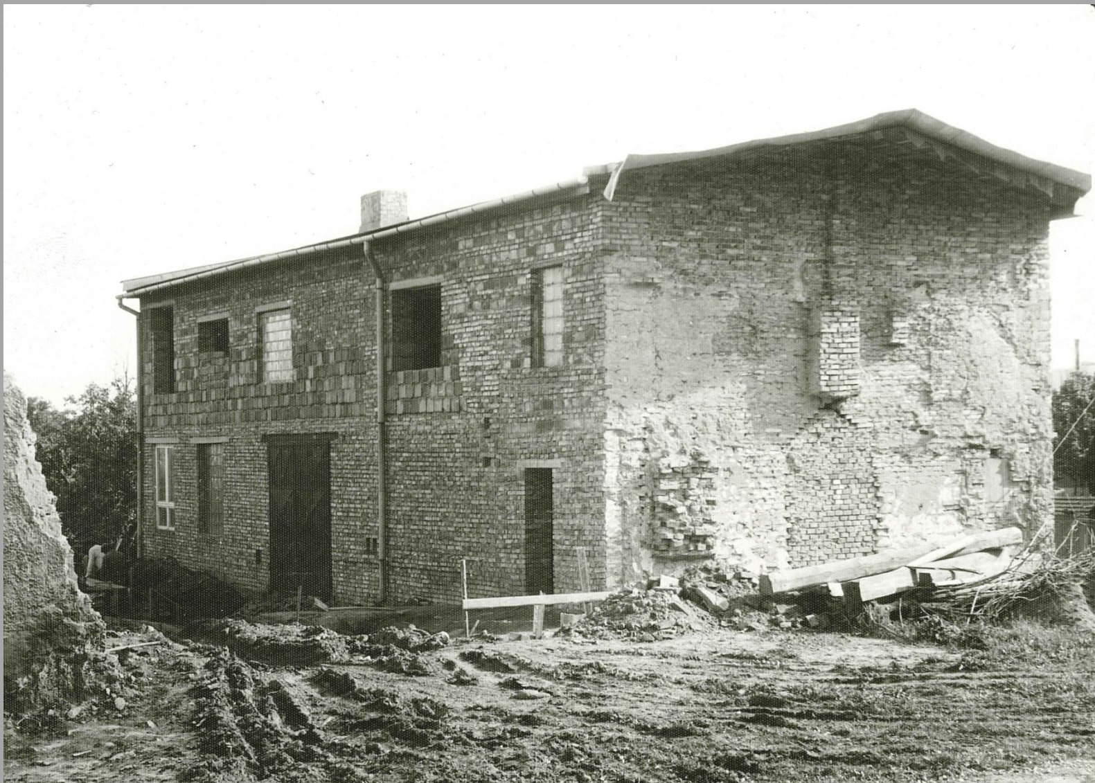
Pohled na přestavovanou hasičskou zbrojnici zezadu.
