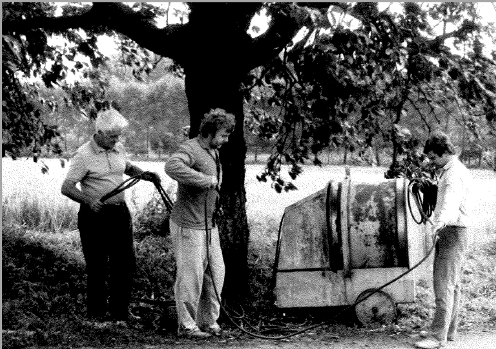
Budování chodníků v Unčicích v roce 1982.
