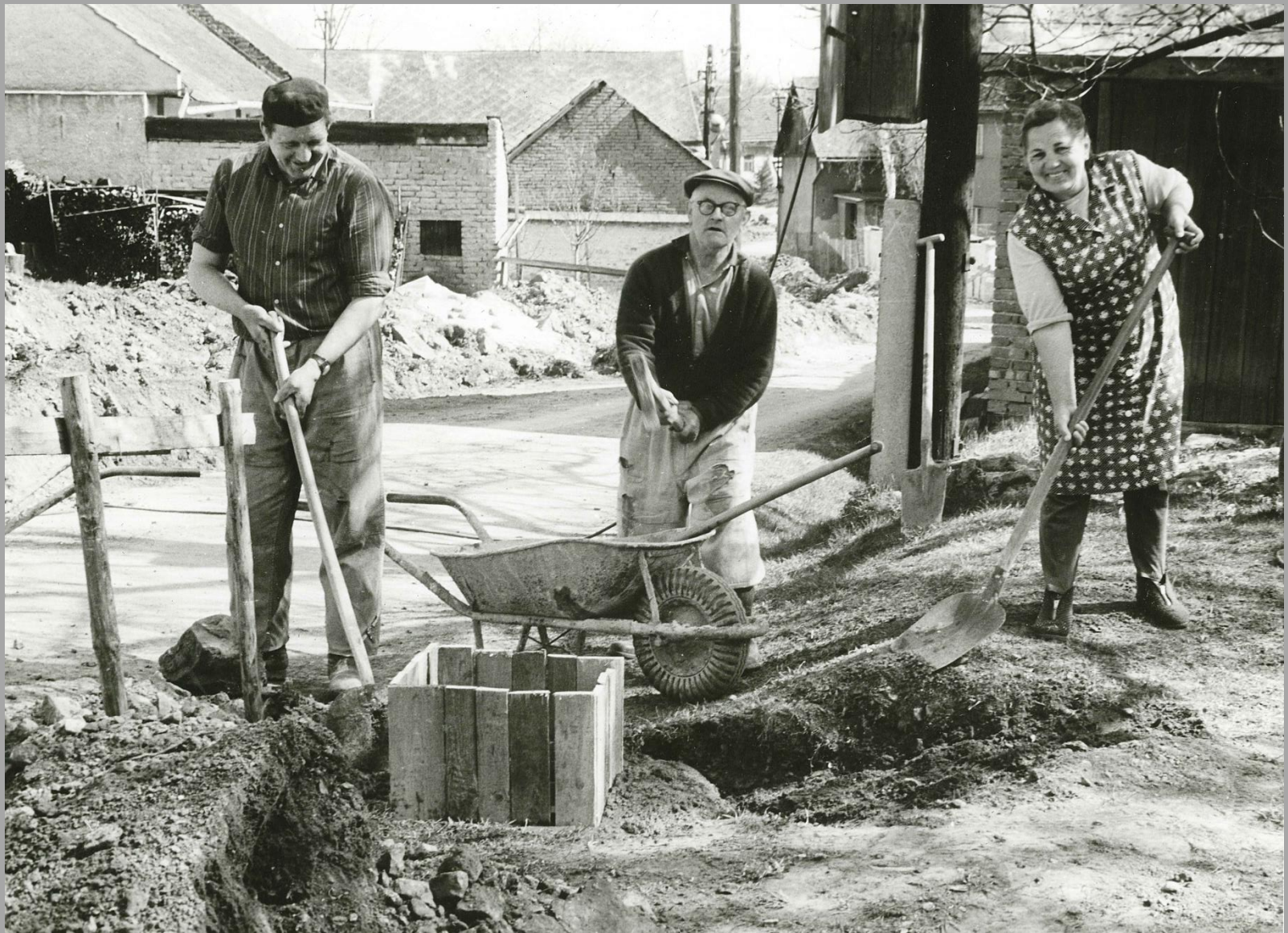
Rok 1983 - pomoc občanů při dokončování kanalizace.
