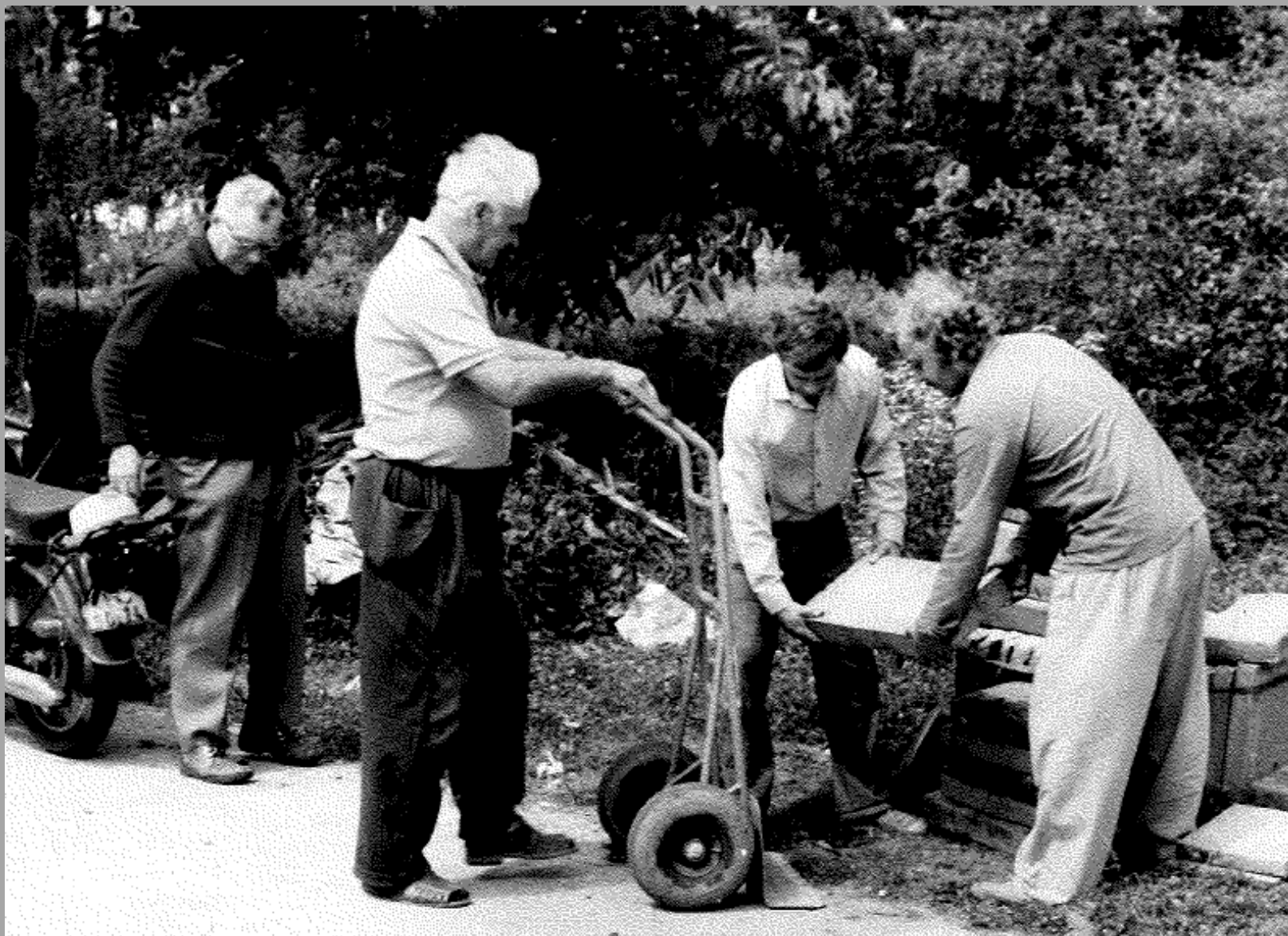
Budování chodníků v Unčičích v roce 1982.
