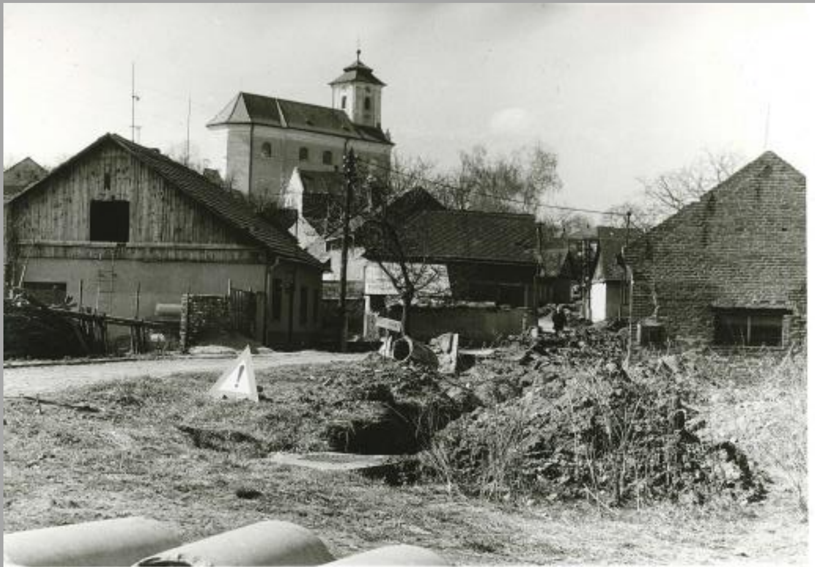
Budování kanalizace v r. 1982.
