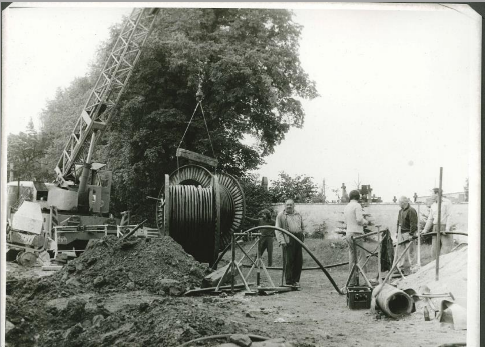
Ukládání kabelů pro mateřskou školu v roce 1981.
