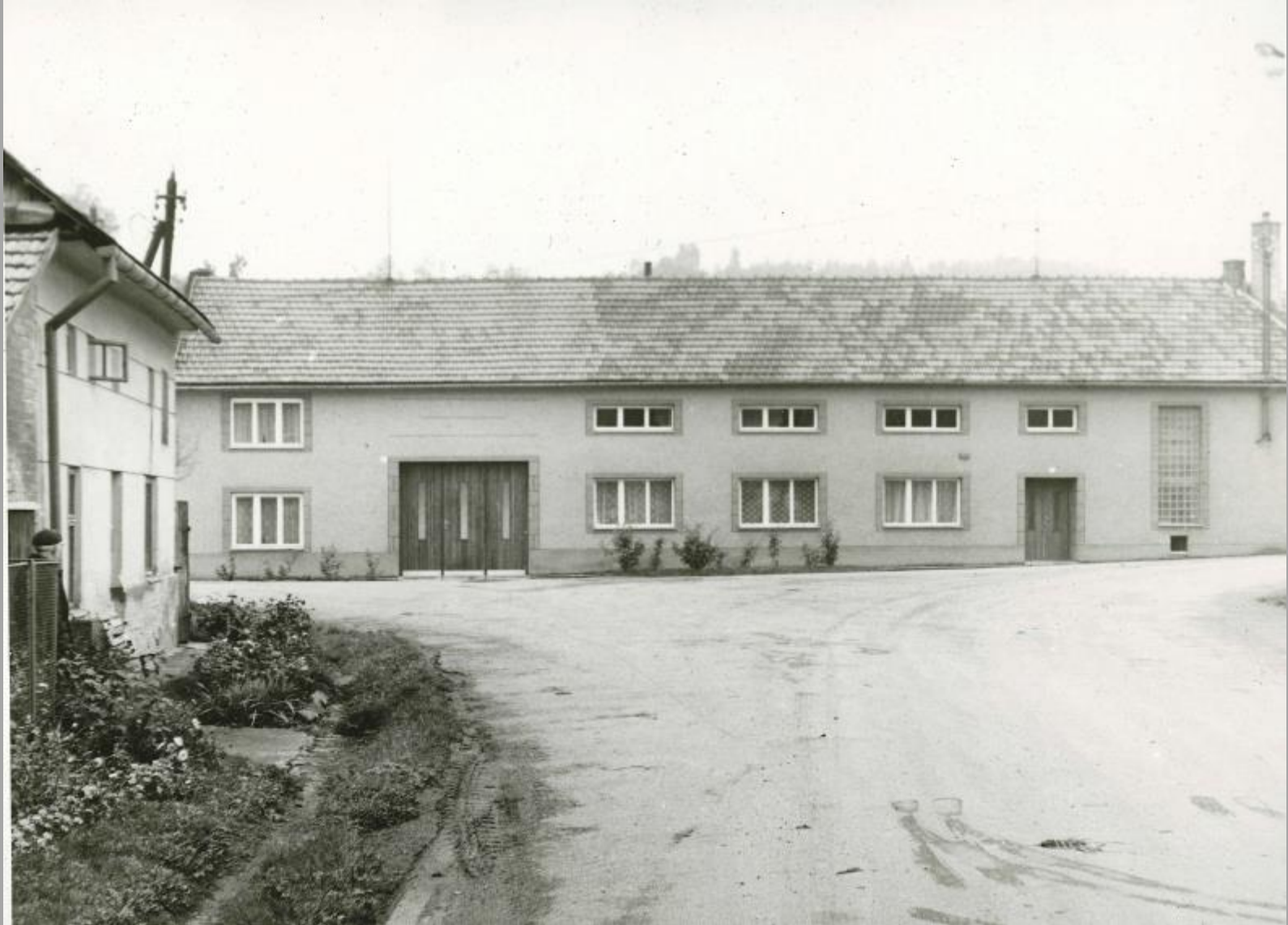
Domy číslo 5. a 6. v majetku rodiny Perutkových. Původně jedna zemědělská usedlost v majetku Jana a Kateřiny Přecechtělových.
