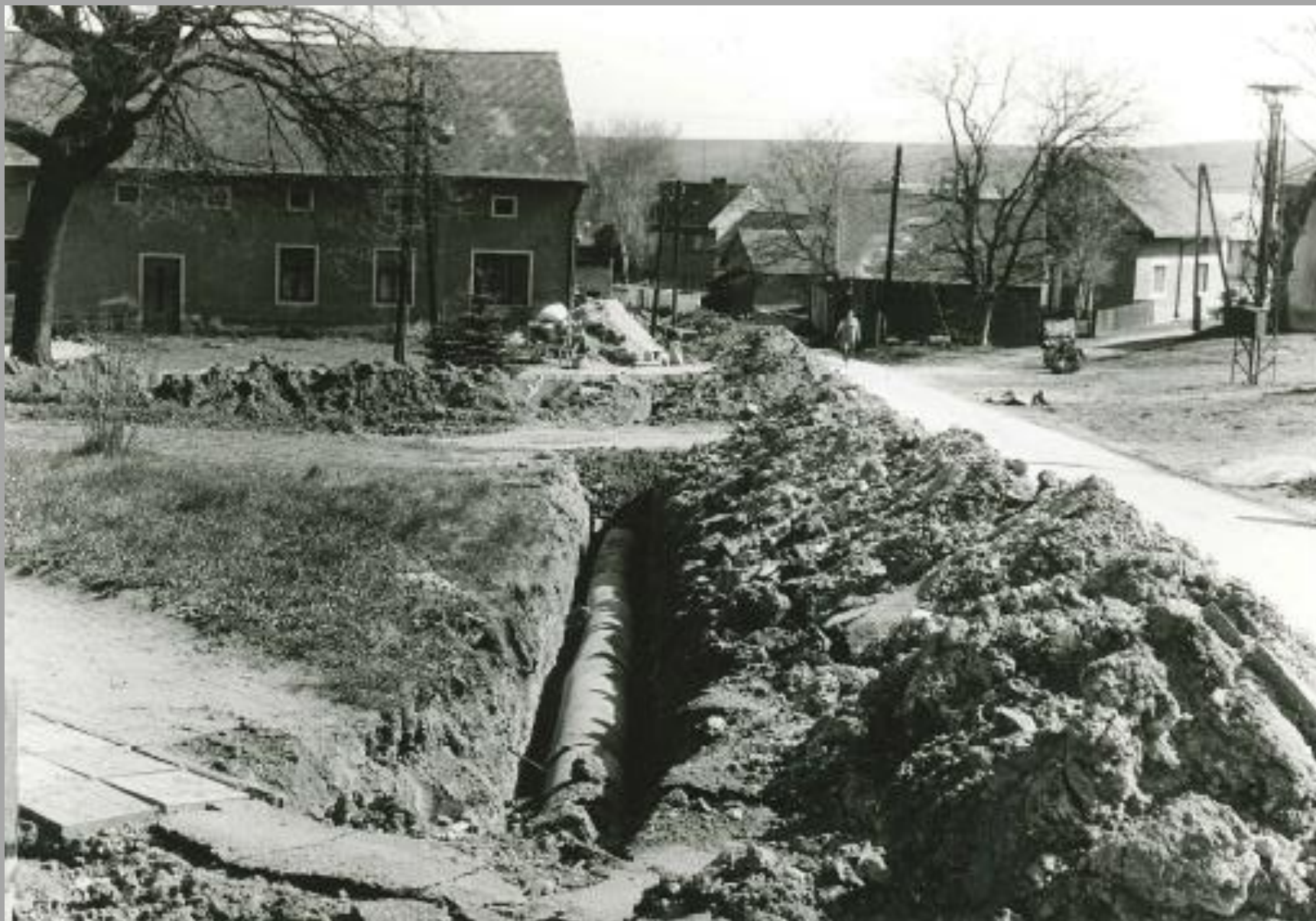
Budování kanalizace v r. 1982.
