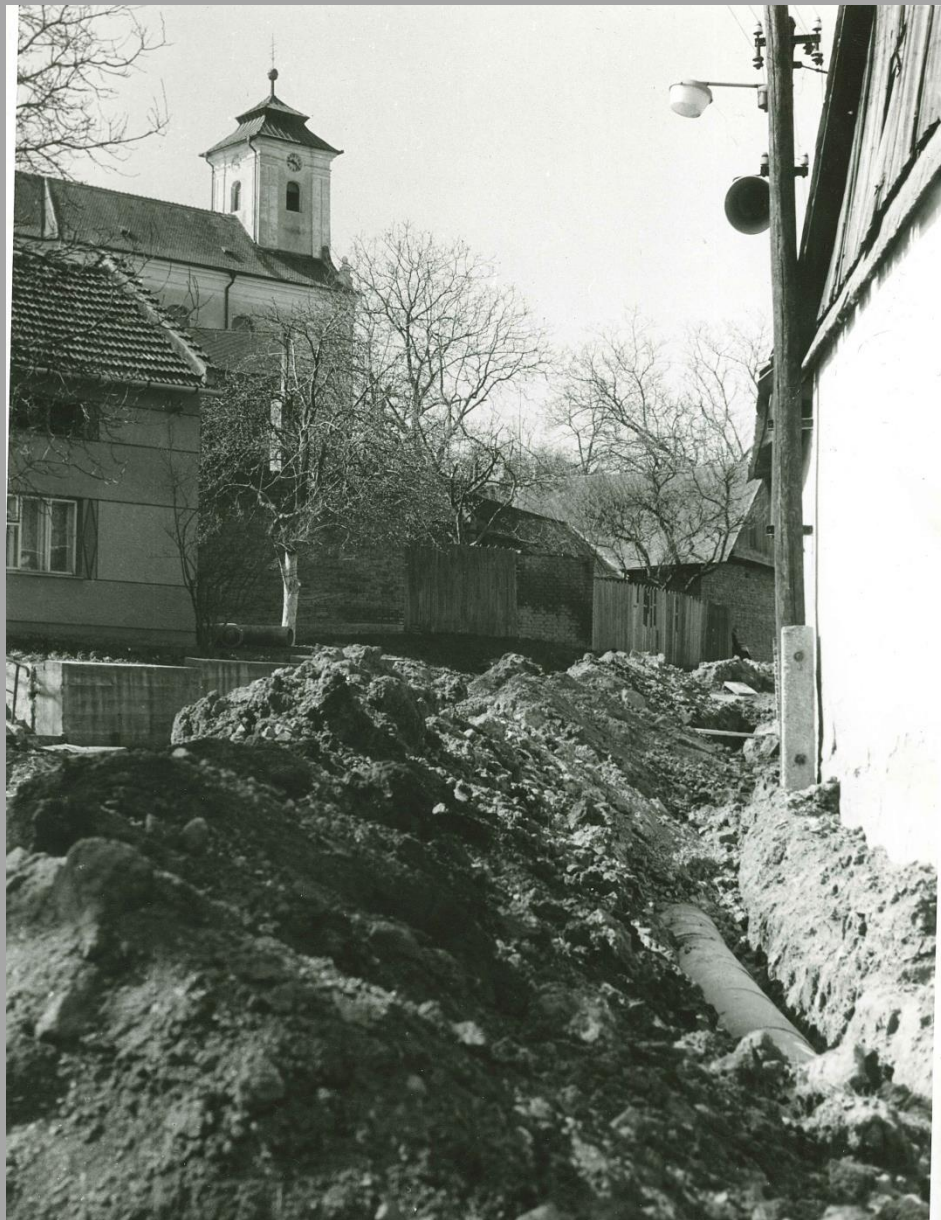
Budování kanalizace v roce 1982.
