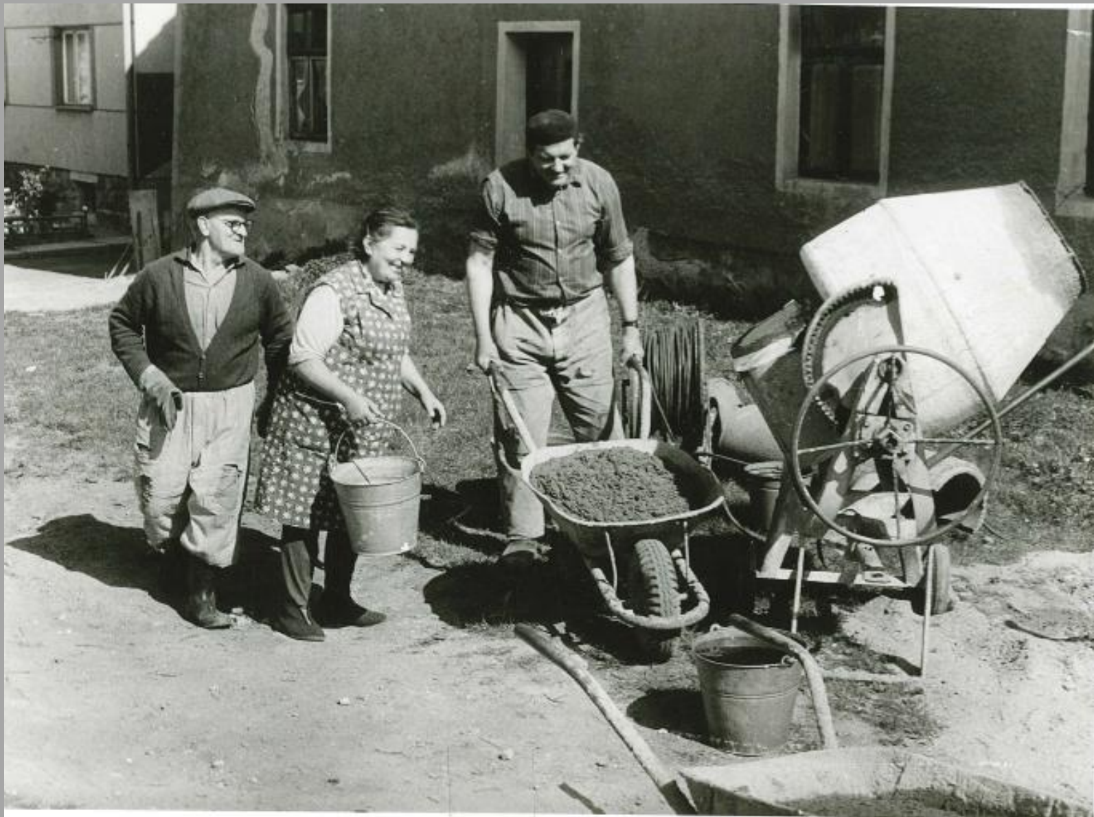
Rok 1983: pomoc občanů při dokončování kanalizace.
